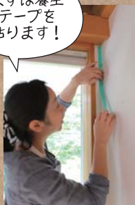
① 養生テープ貼り
