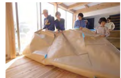
上棟後、約2ヶ月ほどかけて内装工事は無事に完了! 床の養生をみんなで剥がす瞬間は感動もの。
