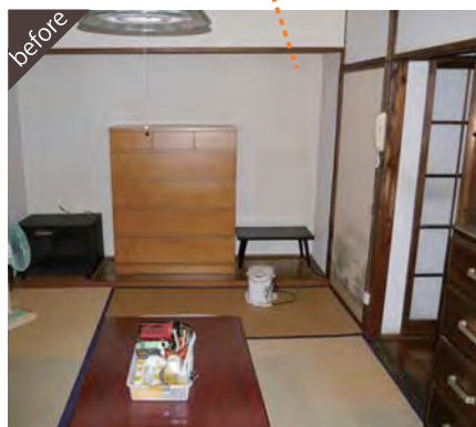
もともと和室だったところを改修し、新しくキッチンを設置しました。
