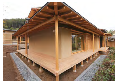
上:美しい丸太の桁に職人の技が光ります。 左:家を囲む濡れ縁。
