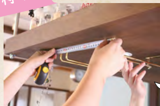
①金具を付ける位置を測る
