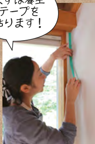
①養生テープ貼り
