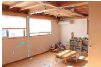
間仕切り前…部屋の中心に壁を設置します。
