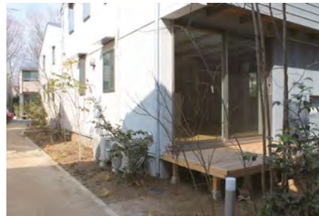
13号棟のデッキを園路から見たところ。
