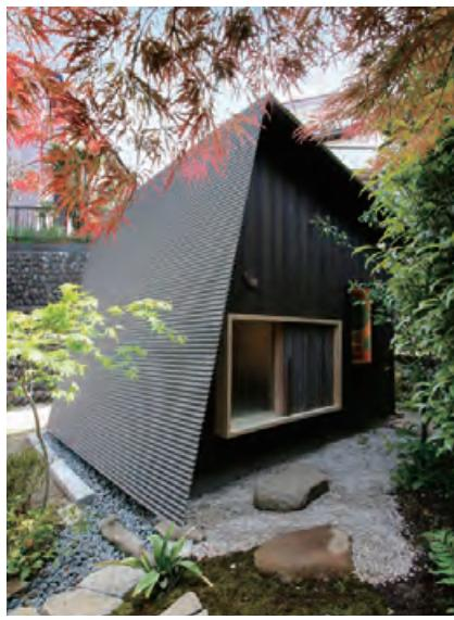
茶室。にじり口の扉は材木を乾燥させる際の桟木を用いた。ステンドグラスにより陽と色のうつろいを表現している。
