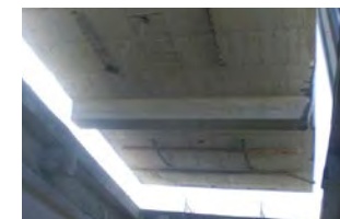
切断し吊り上げられる3階床スラブ。
