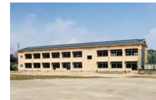
改修後の南側外観。3階を減築して集熱屋根を架け、日射遮蔽の庇を付けた。
